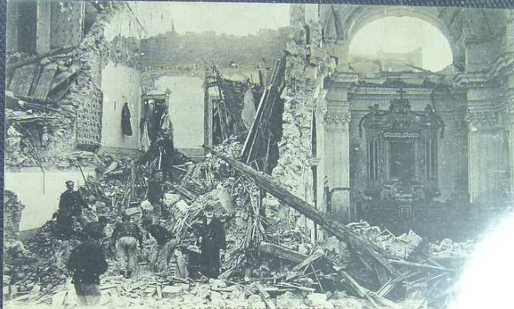
LA CATASTROPHE DE MESSINE 22 Effondrement d'une Chapelle. — ND Phot.
