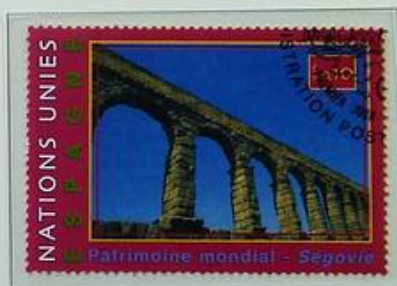
Römische Wasserleitung in Segovia Aqueduc romain de Ségovie
